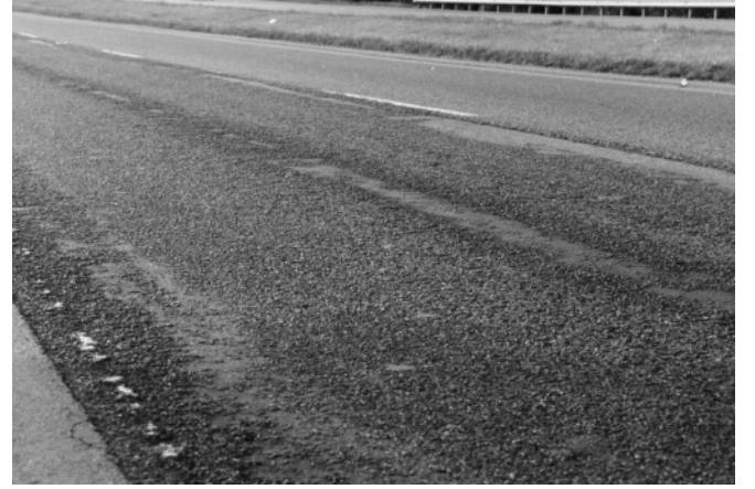
Agrega segregasyonlu asfalt yüzeyi
