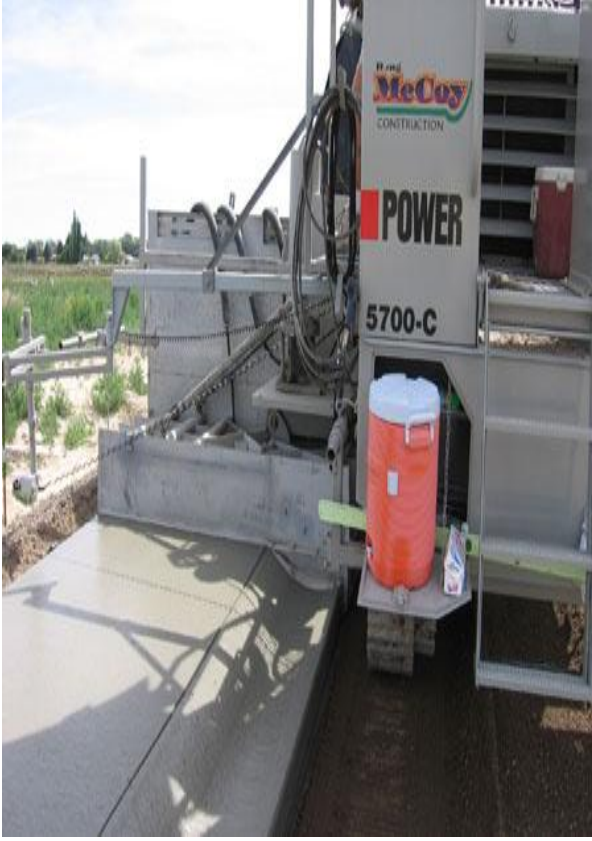
*Yağmur oluklu bordürlü kaldırım uygulaması
