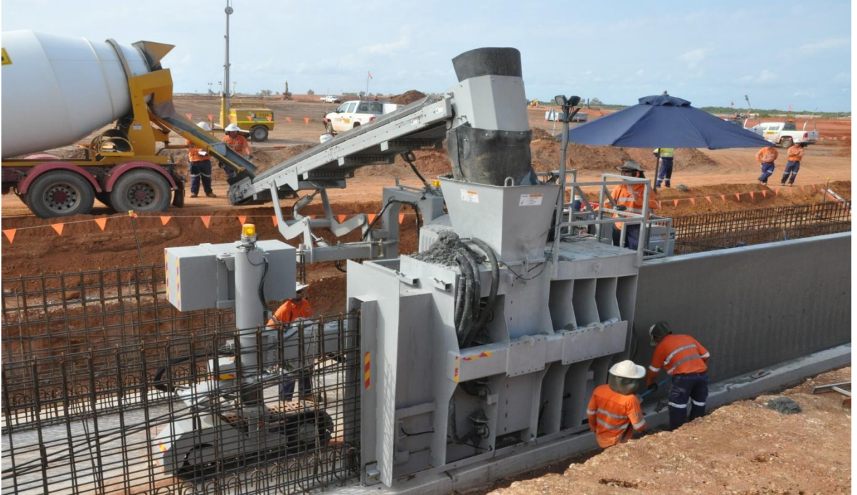
Üç geçişte (pass) donatılı bir sulama kanalının üretiminin yapıldığı bir proje
