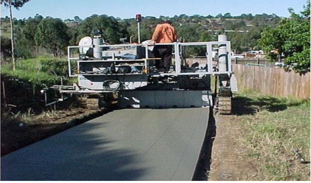
*Beton yürüyüş yolu/ köy yolu uygulaması
